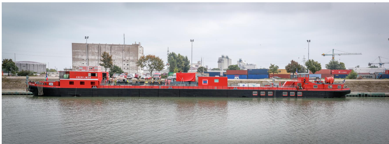
Septembre 2014 – La péniche support du CRERF transformée / September 2014 – umgebautes Übungsschiff
