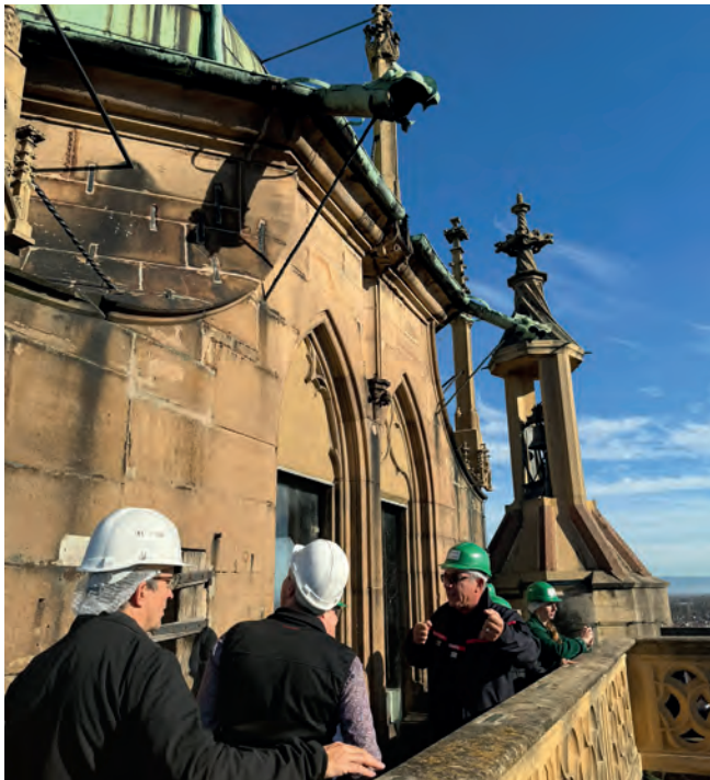
Besuch der Stiftskirche Saint-Martin in Colmar zum Kennenlernen der Brandschutzmaßnahmen
