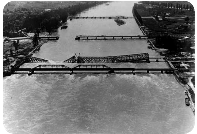
Strasbourg-Kehl: Zerstörte Brücken und Provisorium über den Rhein 1944
